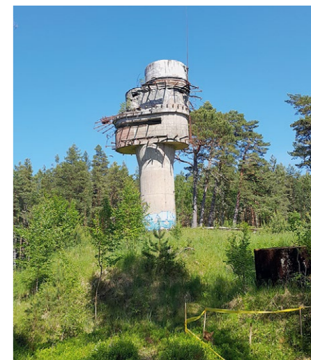
Mežā pie Miķeļbākas netālu no Lūžņas paslēpies šīs Padomju armijas mantojums – Kolkas krasta apsardzes baterija.
